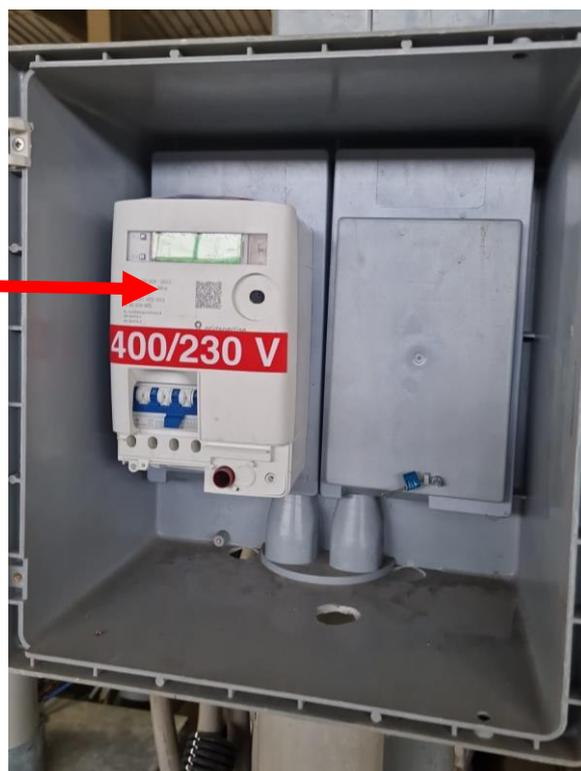
I morsetti del contatore sono il limite che divide la responsabilità del Distributore dall'Utente (punto di connessione), da cui parte l'impianto secondario dell'Utente (impianto d'utenza) che è costituito da cavo di collegamento + dispositivo generale (DG) e deve essere eseguito a regola d'arte e come previsto dalla Norma CEI 0-21 (rif. 7.4.4 Impianto di utenza per la connessione).
