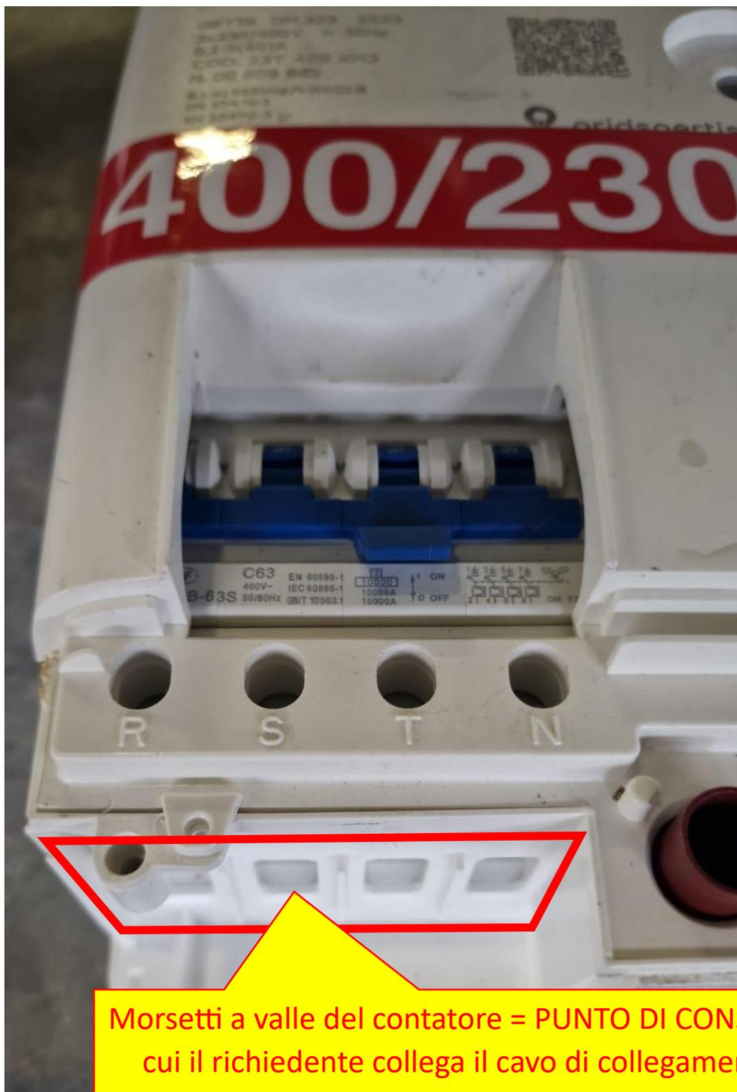
Morsetti a valle del contatore = PUNTO DI CONSEGNA, a cui il richiedente collega il cavo di collegamento e il dispositivo generale (DG) come da Norma CEI 0-21
